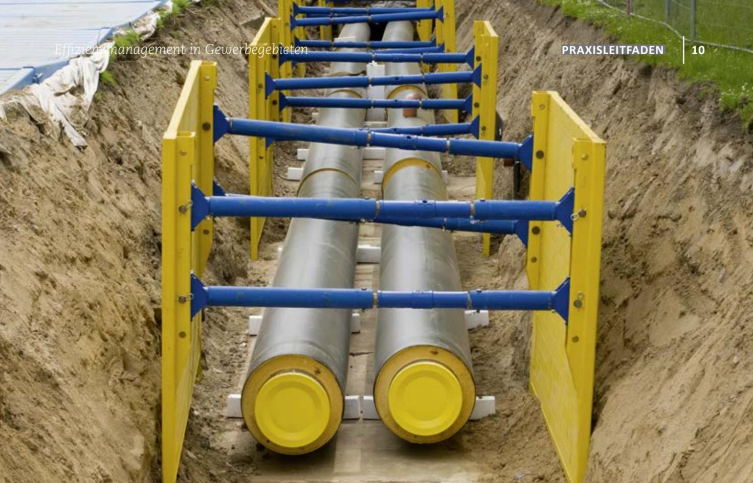
Verlegung einer neuen Wärmeleitung mit zwei Leitungssträngen
