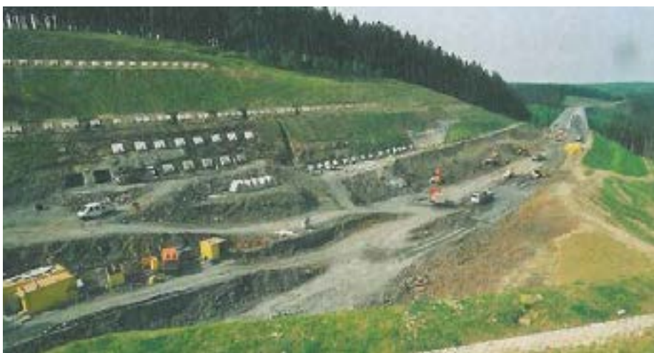
Am 20. Oktober 2003 wurde das 4,7 Kilometer lange A46-Teilstück zwischen Arnsberg-Uentrop und Meschede-Freienohl freigegeben. Die Sicherung des abgebildeten Hanges Müllerhellscheid führte zu einer Bauzeitverlängerung von einem Jahr.
